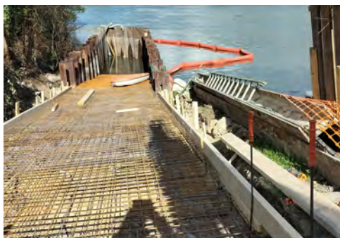
La cale est prête pour le bétonnage
