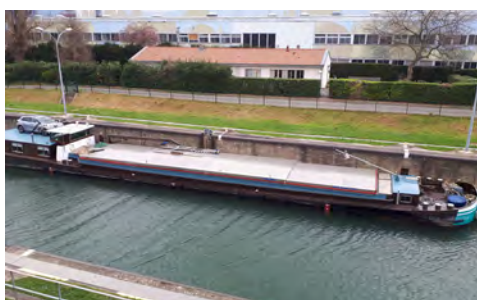
Le sas de l'écluse au gabarit européen
