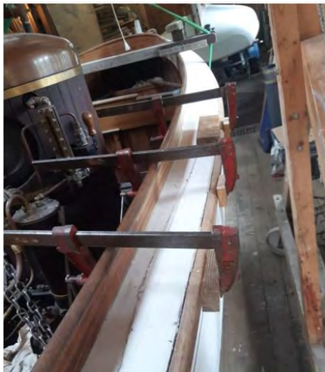
Rattrapage de la fissure par serre-joints
