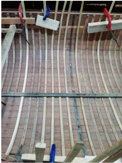
Remplacement des membrures
