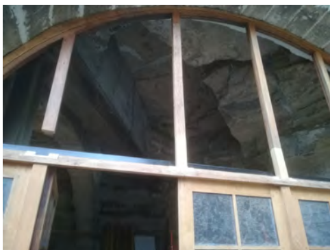
Rénovation des portes du garage et de l'atelier
