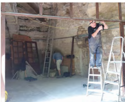
Guy d'Houilles dans ses œuvres, installation du cadre métallique
