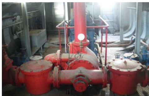
Pompe principale entraînée par le moteur SOMUA
