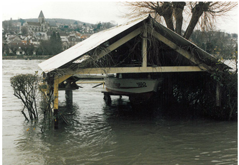
La terrasse lors de la crue de 1995
